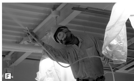
A / 壁面をガイナで施工したパチンコフロアー B / カウンターでもECO店舗であることを訴求 C / 清潔感溢れる休憩スペース D / パチンコ全台に日本ゲームカードのプラズマクラスターイオンユニットを設置 E / LEDに切り替えた照明 F / 改装中の島田店で特殊塗料「ガイナ」を吹き付ける作業スタッフ G / 改装オープンを目前に控えた島田店
